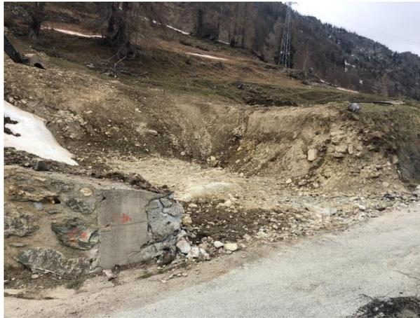
Si calcola quindi, mediante back analysis, l'altezza critica in condizioni drenate, imponendo i parametri di coesione ( $c'$ ), densità ( $\gamma'$ ) e angolo d'attrito ( $\phi'$ ):
