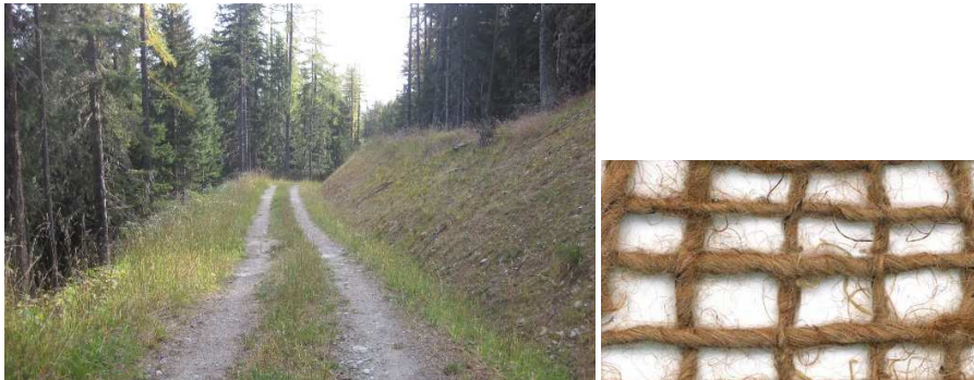
Esempio di scarpate rinverdita a seguito della messa in opera di una geostuoia in fibra di juta (Pista forestale di Frachey – Gignod)
