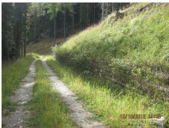
Esempio di palificata in legno rinverdata (Pista forestale di Frachey – Gignod)
