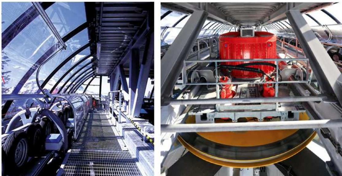
Figura 2-9 Viste interne di una stazione con copertura "tipo alto": tutte le componenti elettromeccaniche sono inserite in un volume chiuso che consente agli addetti alle manutenzioni periodiche ed ai controlli giornalieri di operare in un ambiente protetto dalle i
