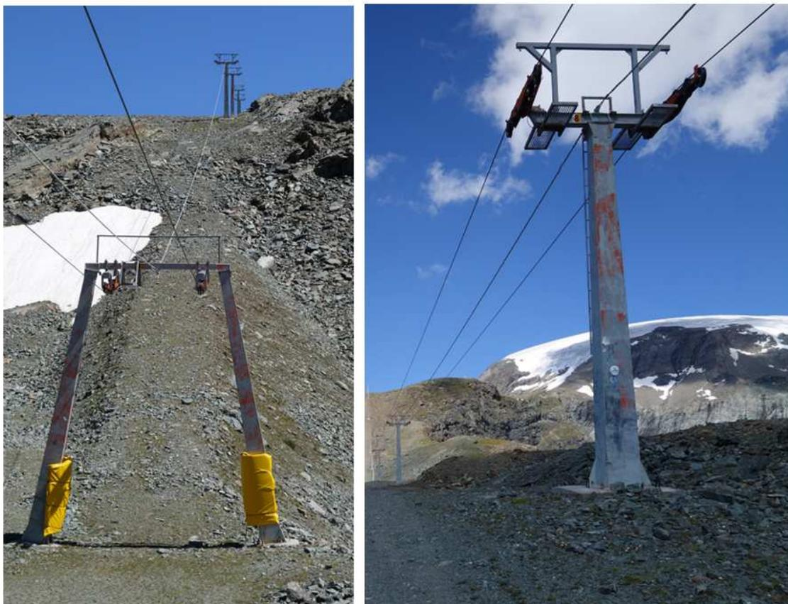
Figura 2-7 In alto a sinistra: sostegno a portale; in alto a destra: sostegno a ritto centrale.
