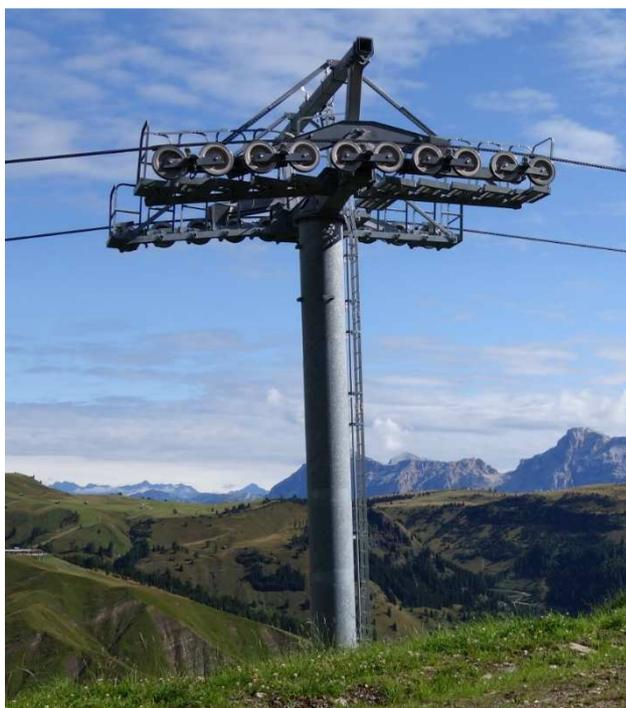
*Figura 2-15 Esempio di sostegno realizzato su una seggiovia esaposto marca Leitner.*
