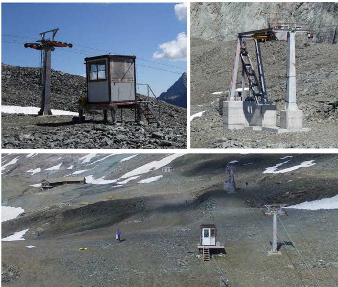
*Figura 2-6 In alto a sinistra: cabina comando; in alto a destra: stazione di rinvio; in basso: vista d'insieme.*
