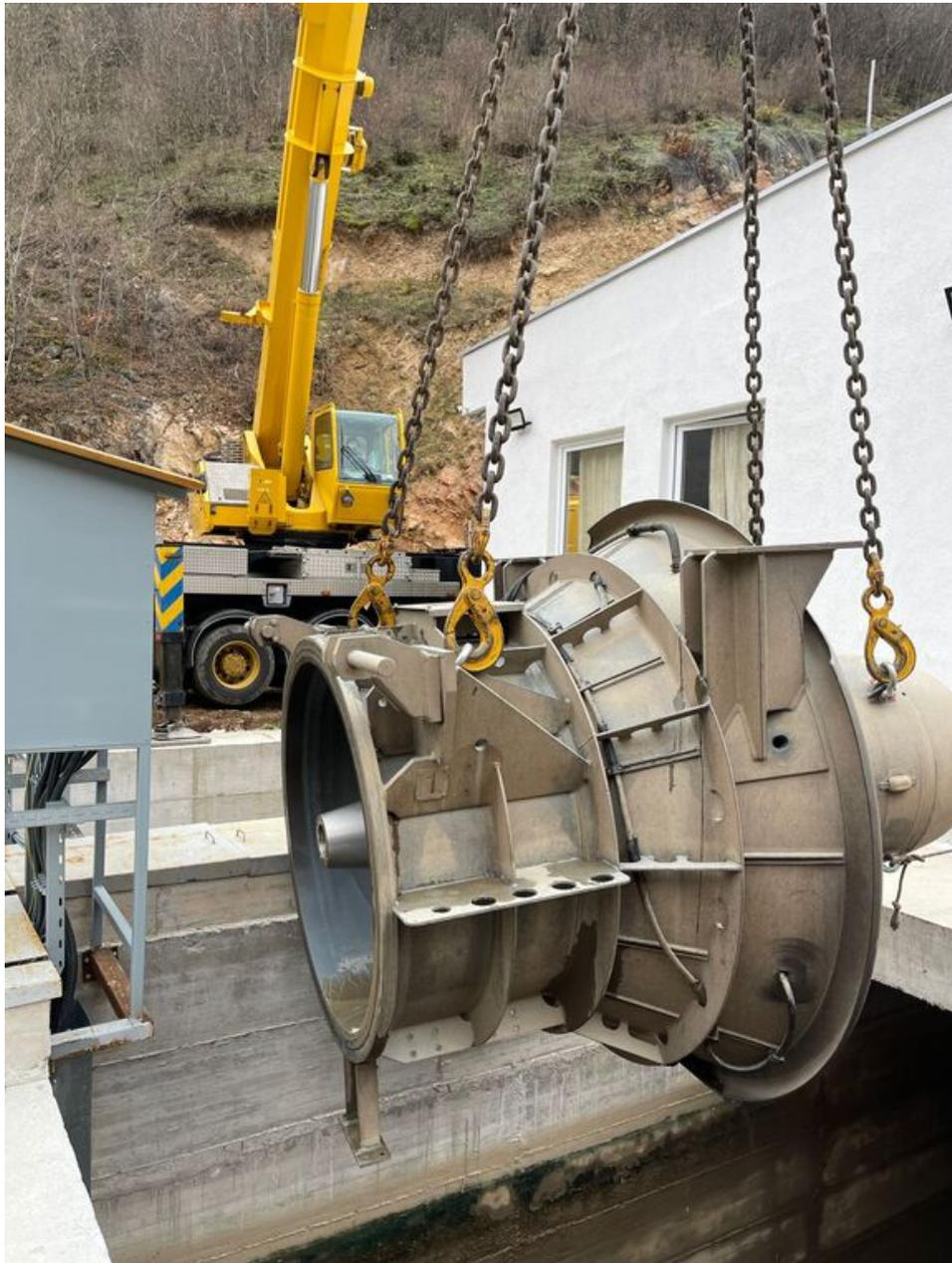
**Figura 7.2:** Gruppo di produzione Kaplan rimosso dalla posizione immersa per manutenzione.
