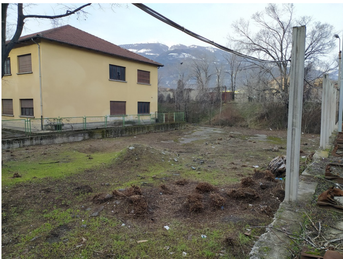
Figura 3.1: Vista dell'area in cui verrà realizzato l'impianto per la produzione di idrogeno.
