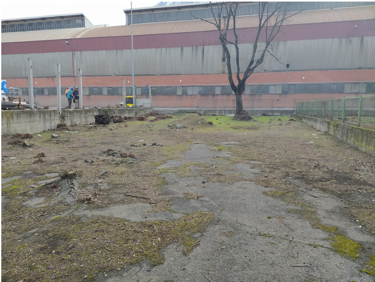
Figura 3.2: Vista dell'area in cui verrà realizzato l'impianto per la produzione di idrogeno.
