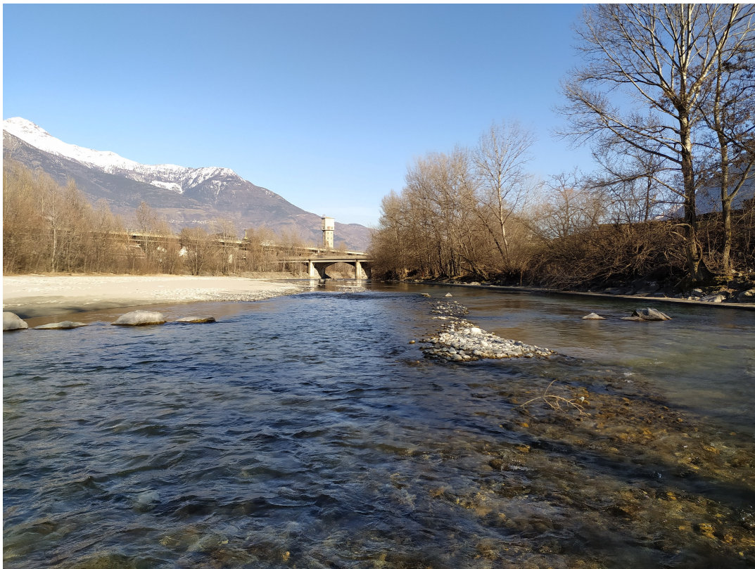
Figura 3.4: Vista da valle dell'attraversamento stradale dell'asta principale della Dora Baltea.
