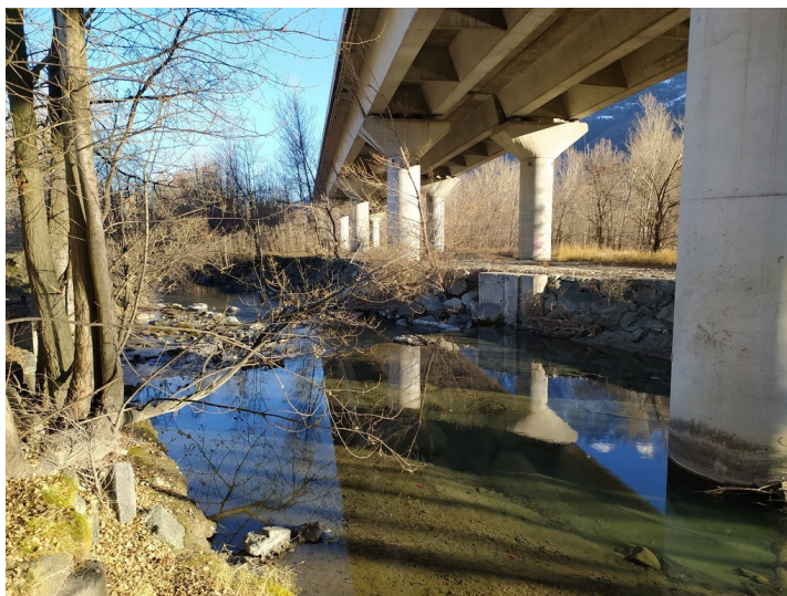
Figura 2.5: Vista del canale Paravera da monte verso valle in prossimità dell'impianto idroelettrico in progetto.
