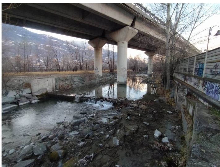
Figura 2.6: Vista del canale Paravera da valle verso monte in prossimità dell'impianto idroelettrico in progetto.
