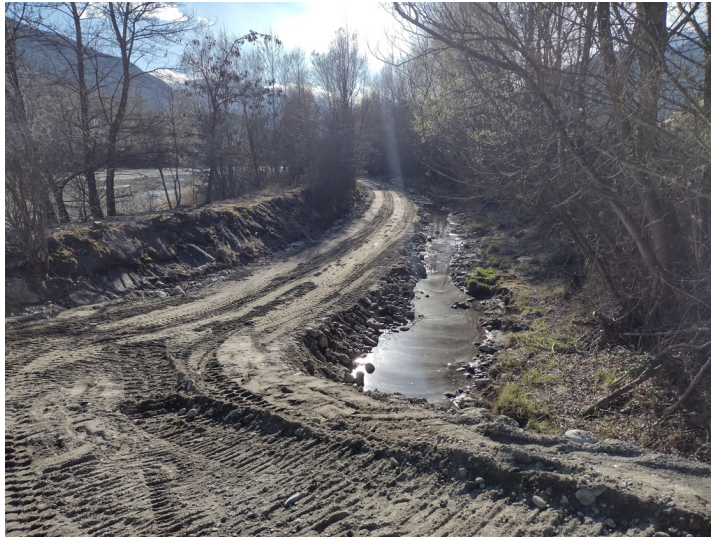
Figura 2.14: Pista provvisoria in alveo per consentire il transito dei camion.
