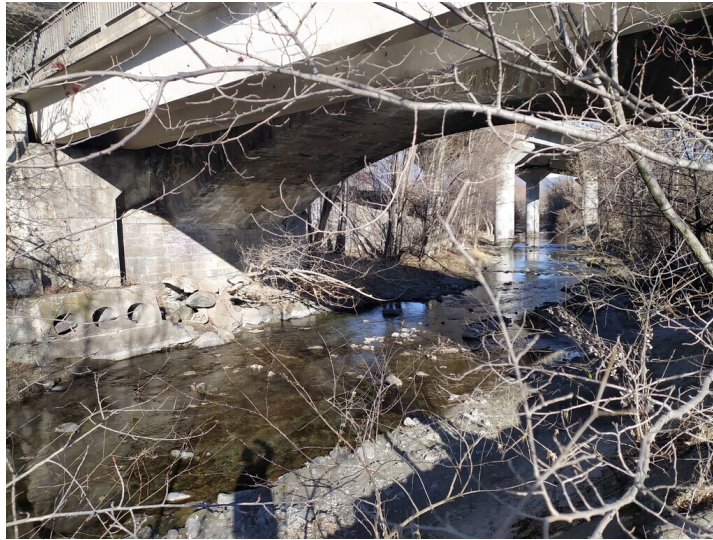
Figura 2.4: Vista del canale Paravera in corrispondenza del ponte.
