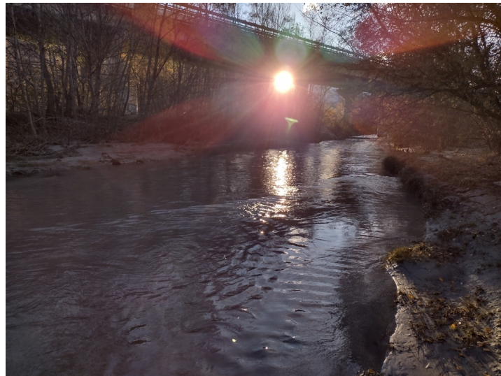
Figura 2.7: Vista del canale Paravera da valle verso monte nella sezione in cui verrà realizzato l'impianto idroelettrico.
