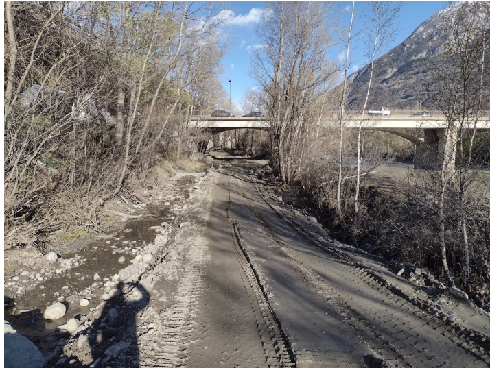
Figura 2.15: Pista provvisoria in alveo per consentire il transito dei camion.
